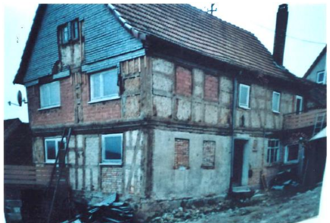
Abbildung 1 Das Fachwerkhaus vor der Sanierung (Foto: Jochen Menninger)
