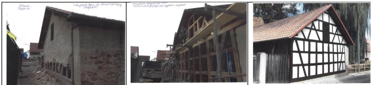
Abbildung 5 Das Nebengebäude: vor, während und nach der Sanierung (Fotos: Schneider)
