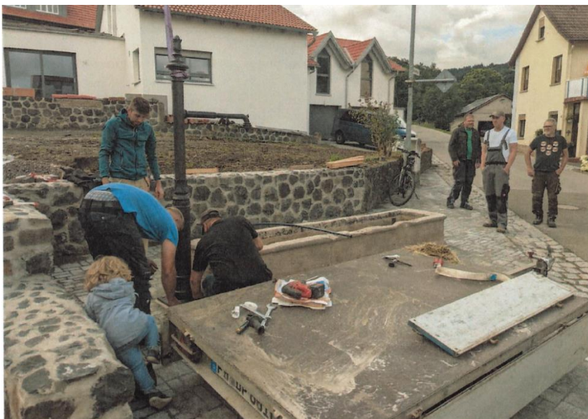
Abbildung 4 Gemeinschaftsarbeit beim Setzen der Brunnensäule (Foto: Markus Grief).
