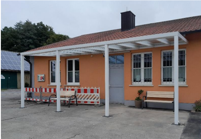
Abbildung 19: Neu überdachter Bushaltebereich am DGH Willmars (Foto: VGem Ostheim)
