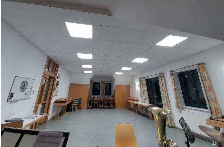
Abbildung 8: Der umgestaltete Deckenbereich des Musikprobenraums bietet bessere Akustik und gleichmäßige Ausleuchtung (Foto: Melanie Scharbert)
