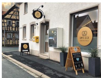
Um's Eck Oberstreu - barrierefreie Toilettenanlage
