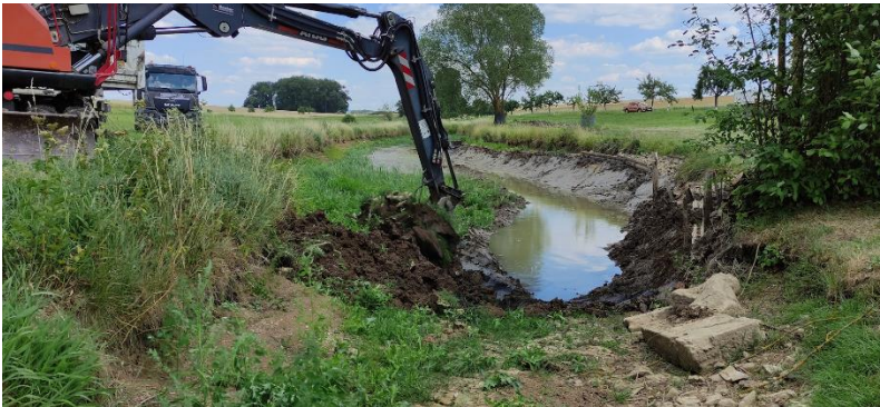
Abbildung 23: Ausbaggern des verlandeten Vorflutbeckens (Foto: Nikolaus Trapp)
