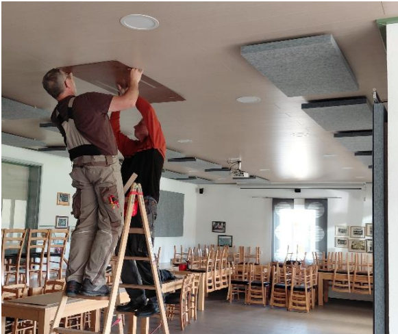
Abbildung 9: Deckenmontage der Akustikvliese (Foto: Julian Trabert)
