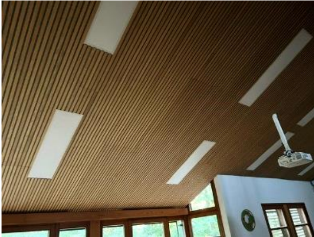
Abbildung 16: Neue Deckenvertäfelung mit Akustikpaneelen einschl. LED-Beleuchtung (Foto: Jürgen Eckert)
