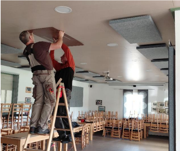
Abbildung 9: Deckenmontage der Akustikvliese (Foto: Julian Trabert)
